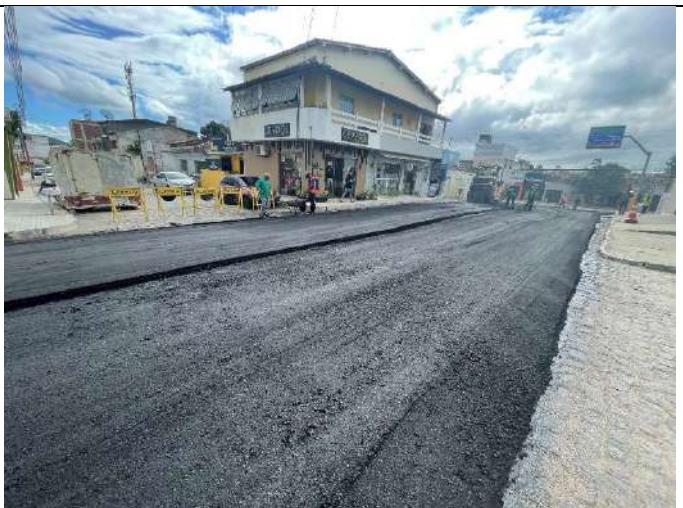
COMPACTAÇÃO DA CAMADA DE ROLAMENTO
