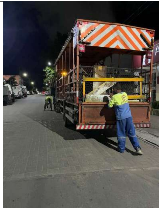
EXECUÇÃO DE SINALIZAÇÃO HORIZONTAL
