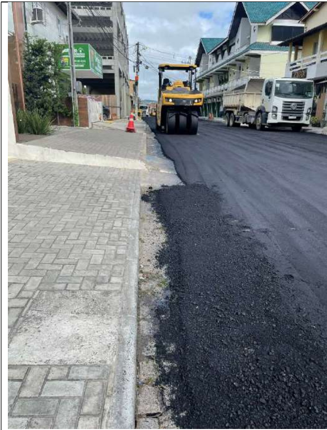
COMPACTAÇÃO DA CAMADA DE ROLAMENTO
