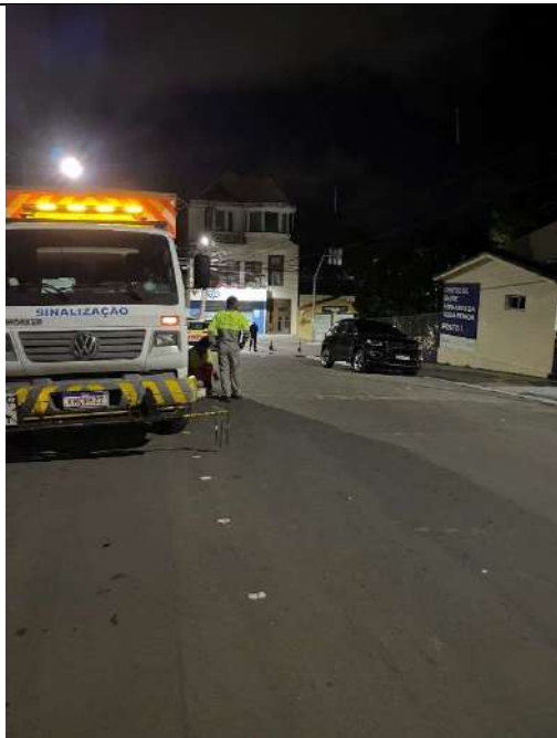
EXECUÇÃO DE SINALIZAÇÃO HORIZONTAL
