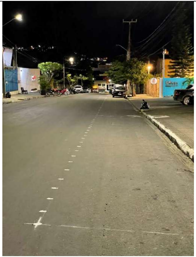
EXECUÇÃO DE SINALIZAÇÃO HORIZONTAL
