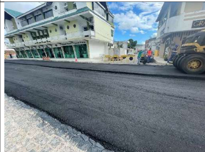
COMPACTAÇÃO DA CAMADA DE ROLAMENTO
