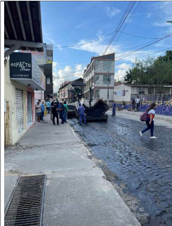
EXECUÇÃO DE IMPRIMAÇÃO
