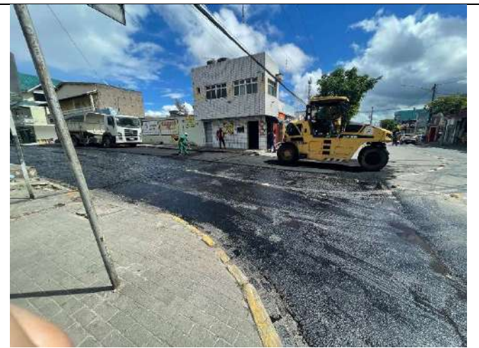
EXECUÇÃO DE IMPRIMAÇÃO
