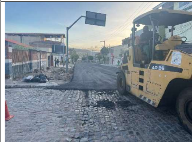
APLICAÇÃO DA CAMADA DE ROLAMENTO
