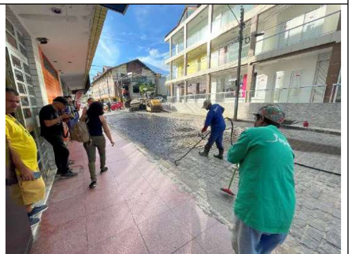
EXECUÇÃO DE IMPRIMAÇÃO
