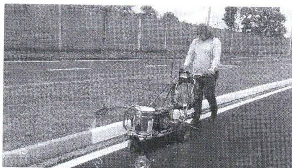
*Pintura de meio fio por meio de máquina Airless p/ Sinalização Viária
