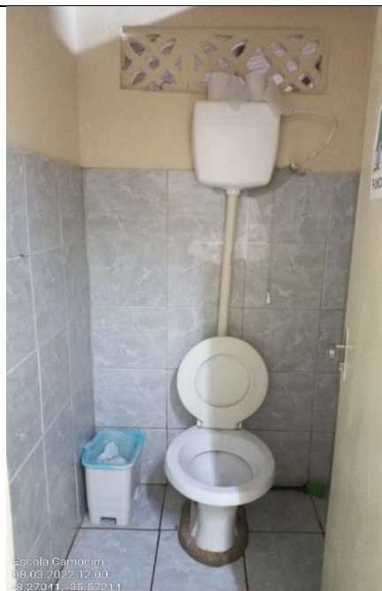
Escola Municipal Camocim - Banheiro
