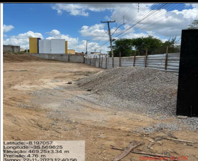
LIMPEZA DE TERRENO
