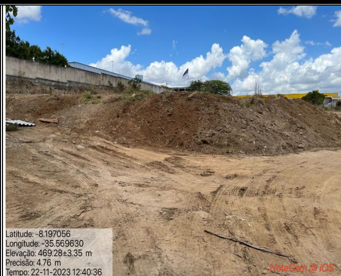
LIMPEZA DE TERRENO
