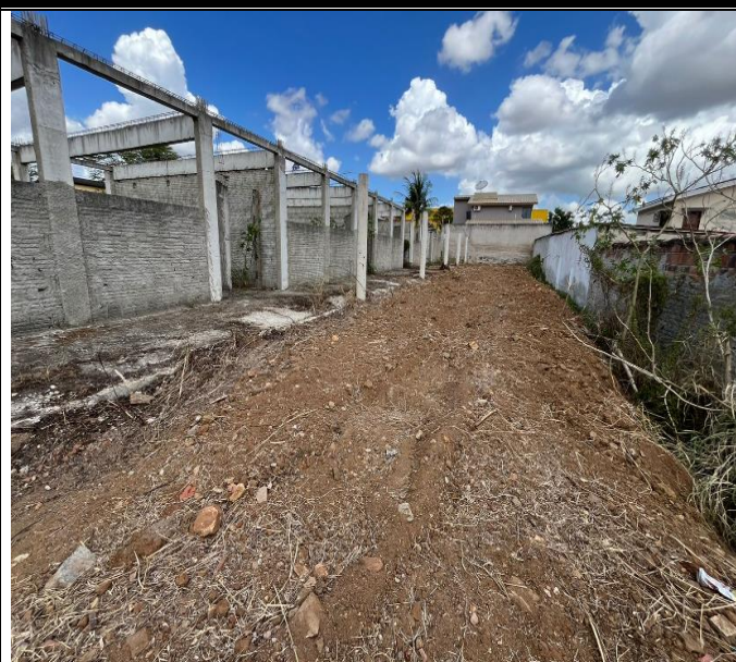
LIMPEZA DE TERRENO
