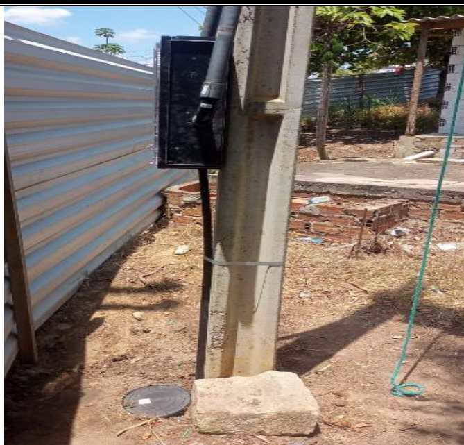
INTALAÇÃO ELÉTRICA PROVISÓRIA
