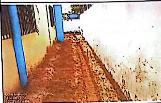
FOTO 01: Vala para passagem dos tubos.
