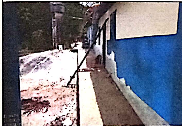
FOTO 05: Execução de passeio da rampa.
