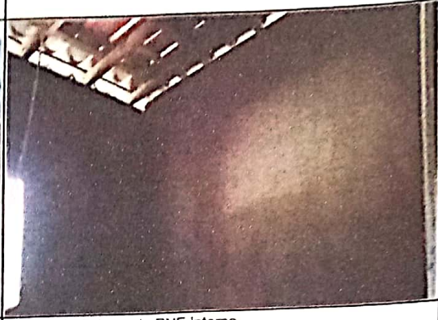
FOTO 02: Emboço do PNE interno.
