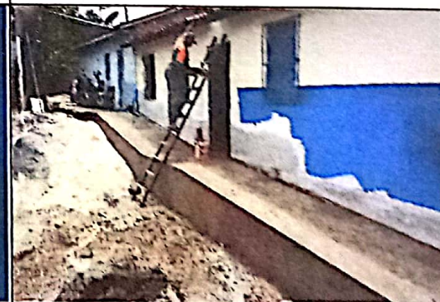
FOTO 06: Massa única da rampa.
