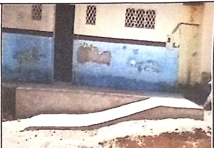
FOTO 08: Execução de passeio na rampa de acesso .
