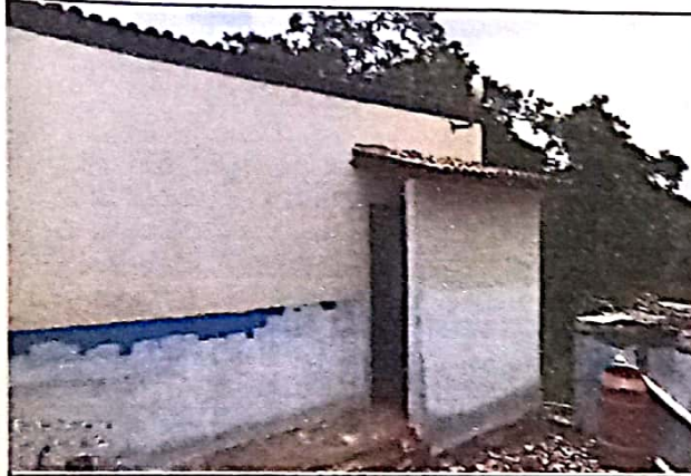
FOTO 03: Trama de madeira e telhamento com telha cerâmica do PNE.
