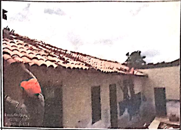
FOTO 08: Revisão de coberta.
