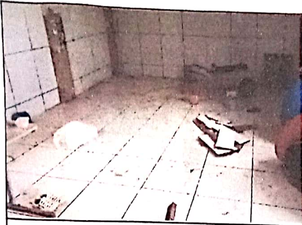
FOTO 07: Revestimento cerâmico do piso da sala de aula.
