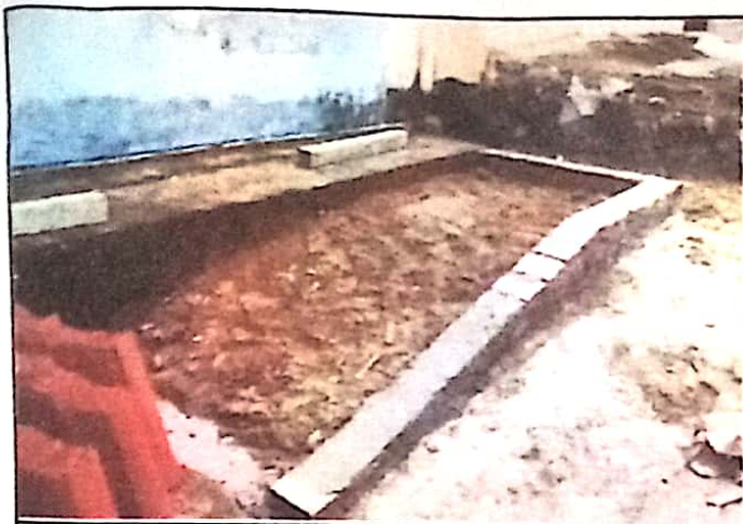
FOTO 07: Alvenaria de embassamento da rampa de acesso.
