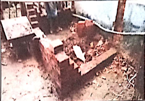
FOTO 01: Alvenaria de embassamento do PNE.
