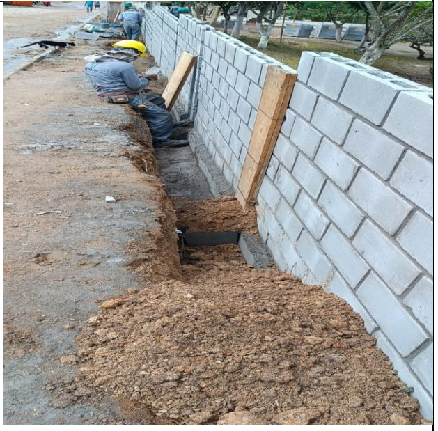
FOTO 12: REATERRO DAS VALAS E SAPATAS 02
