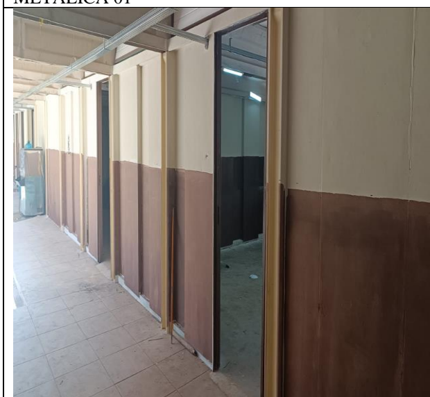
FOTO 15: EXECUÇÃO DE PINTURA DA CRECHE 01
