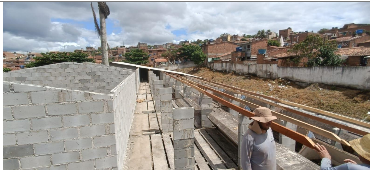
FOTO 08: INSTALAÇÃO DE LINHAS- COBERTA CRECHE.
