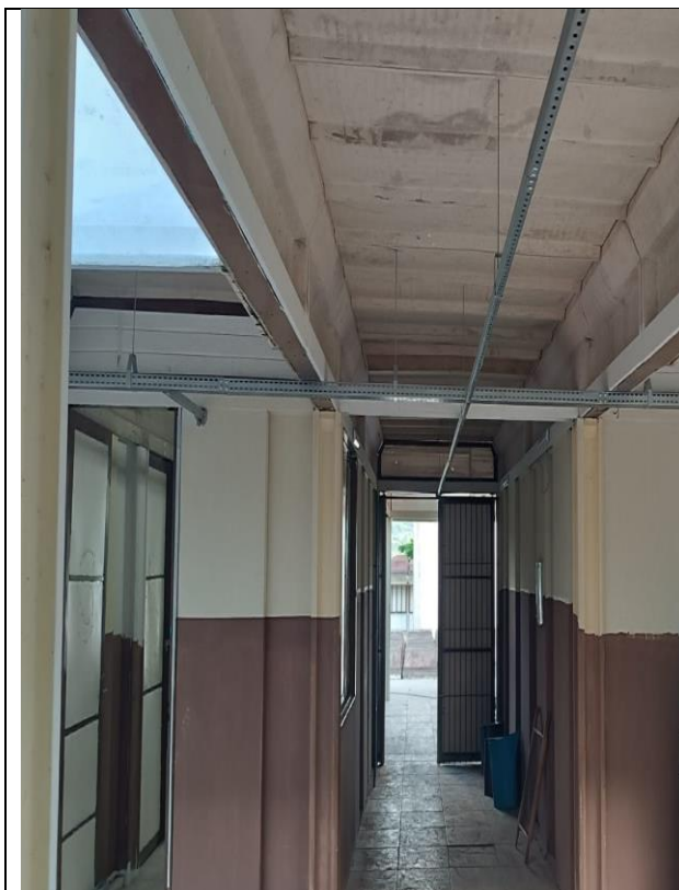
FOTO 13: INSTALAÇÃO DE ELETROCALHA METALICA 01
