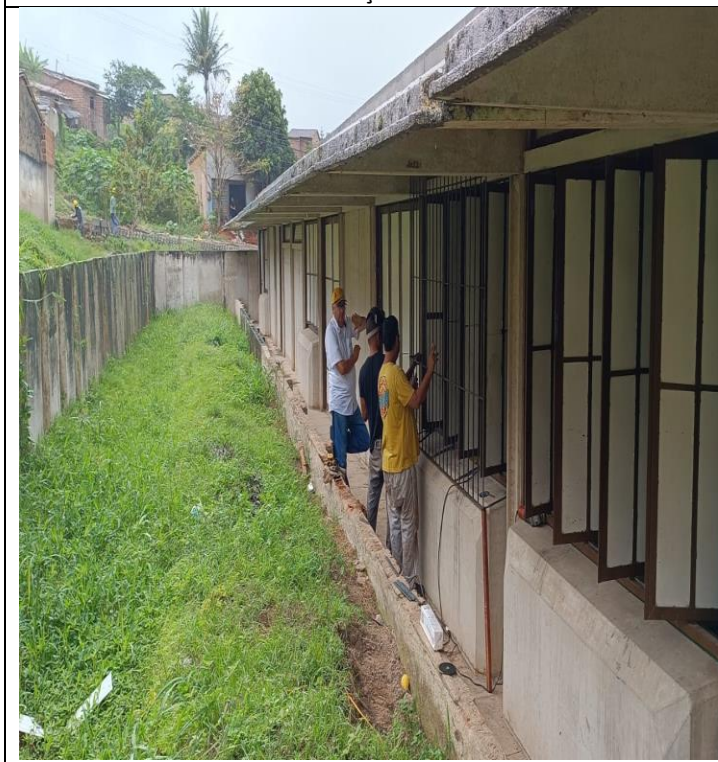
FOTO 06: INSTALAÇÃO DE GRADES DE PROTEÇÃO
