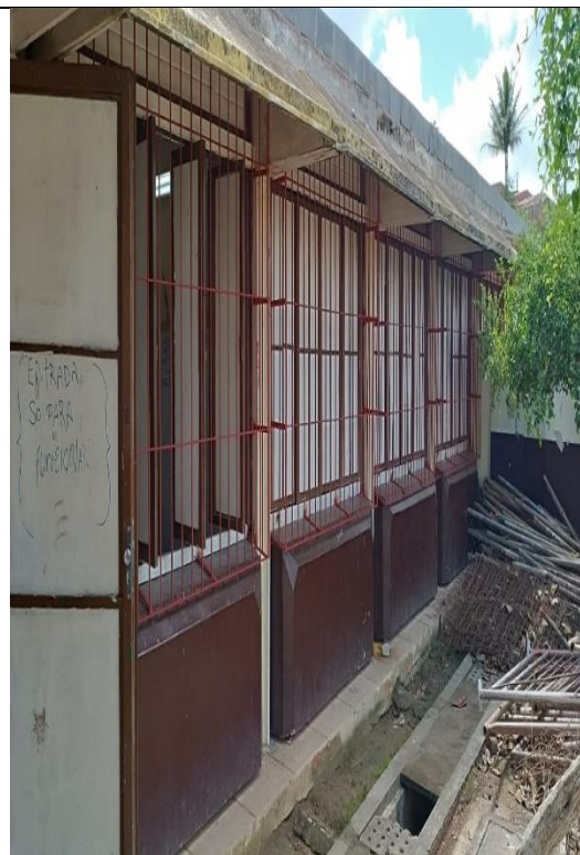
FOTO 07: GRADES DE JANELAS
