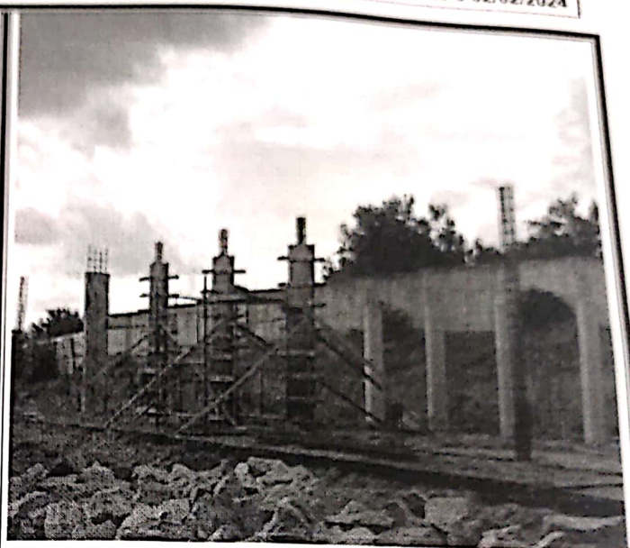
FORMA, CONCRETO E ARMAÇÃO DE PILAR
