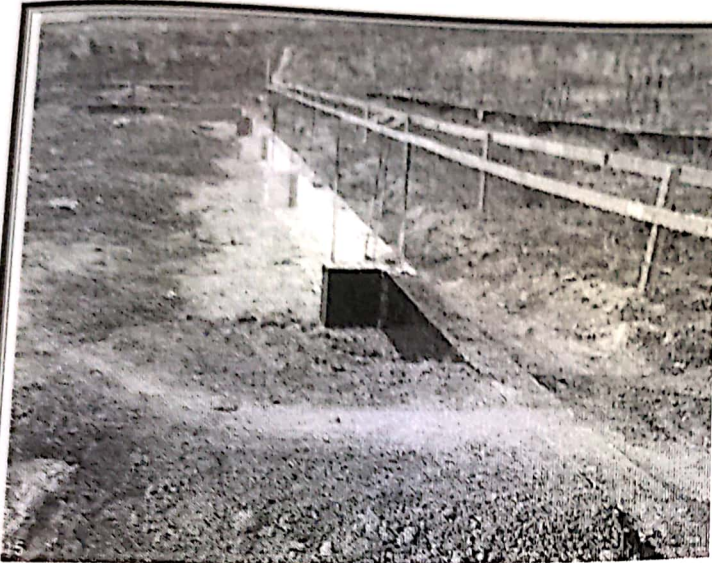
LOCAÇÃO DA OBRA
