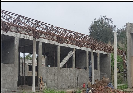
FOTO 04: Estrutura metálica dos blocos C, D, A e G.
