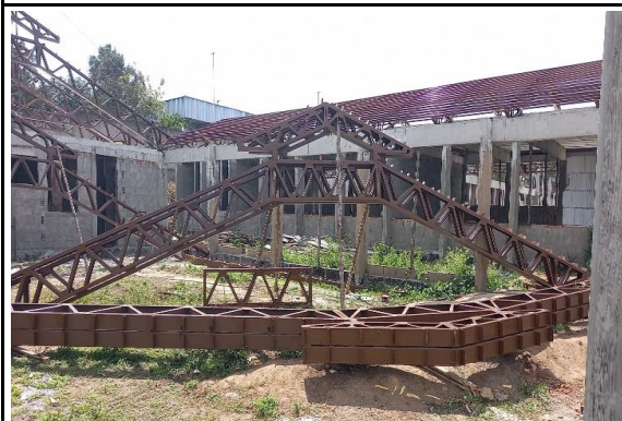
FOTO 05: Estrutura metálica dos blocos C, D, A e G.
