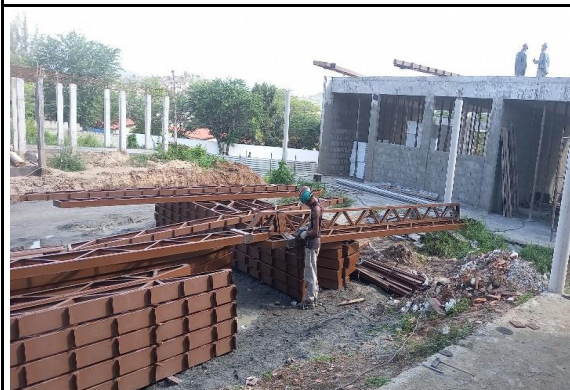
FOTO 03: Estrutura metálica dos blocos C, D, A e G.
