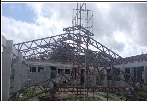
FOTO 06: Estrutura metálica dos blocos C, D, A e G.
