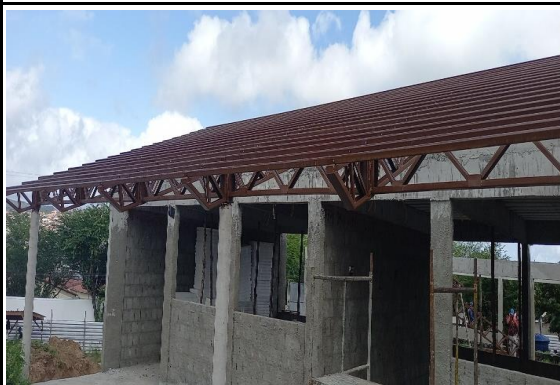
FOTO 08: Estrutura metálica dos blocos C, D, A e G.
