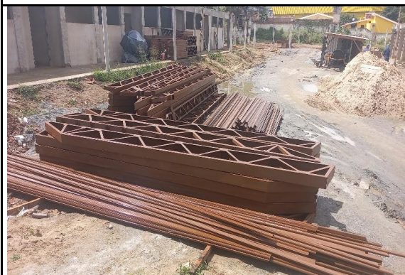
FOTO 01: Estrutura metálica dos blocos C, D, A e G.
