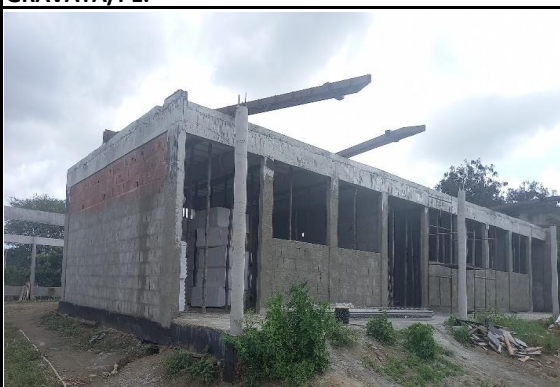
FOTO 02: Estrutura metálica dos blocos C, D, A e G.
