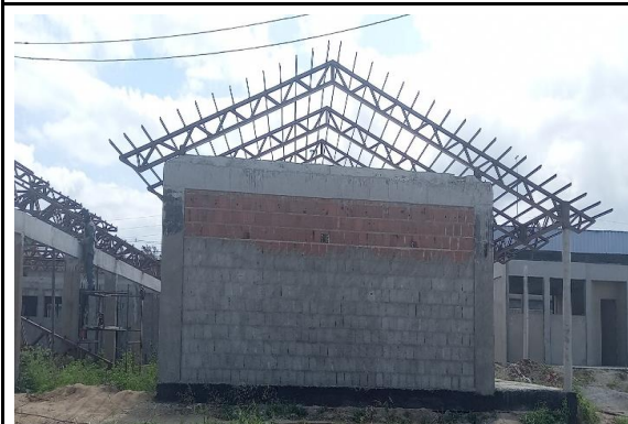
FOTO 07: Estrutura metálica dos blocos C, D, A e G.
