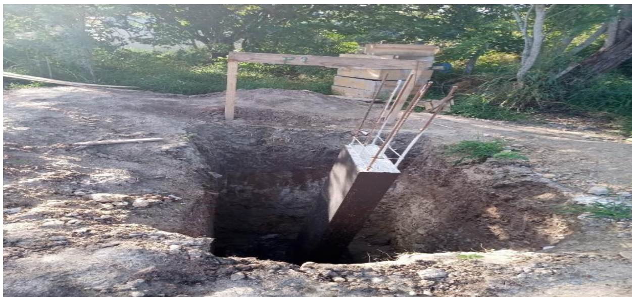
Figura 10- Concreto/ impermeabilização / aço / forma
