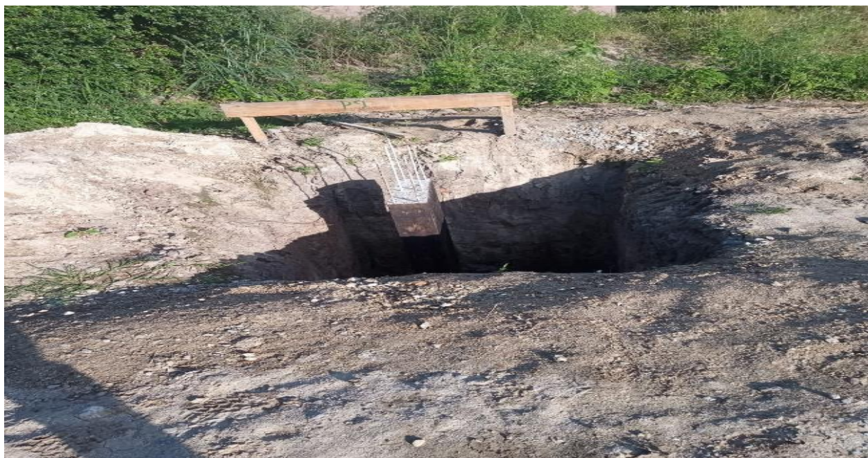
Figura 11 – aço / concreto / forma
