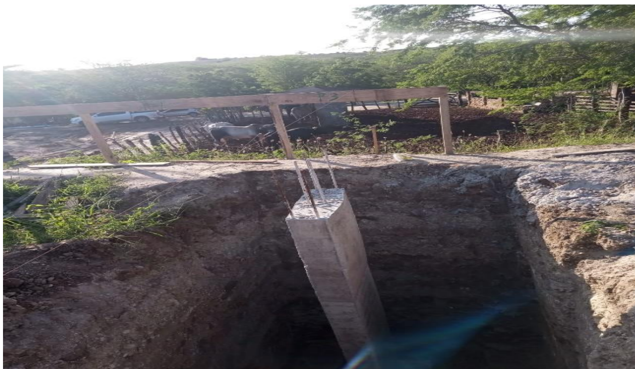
Figura 8 – Escavação / aço / concreto
