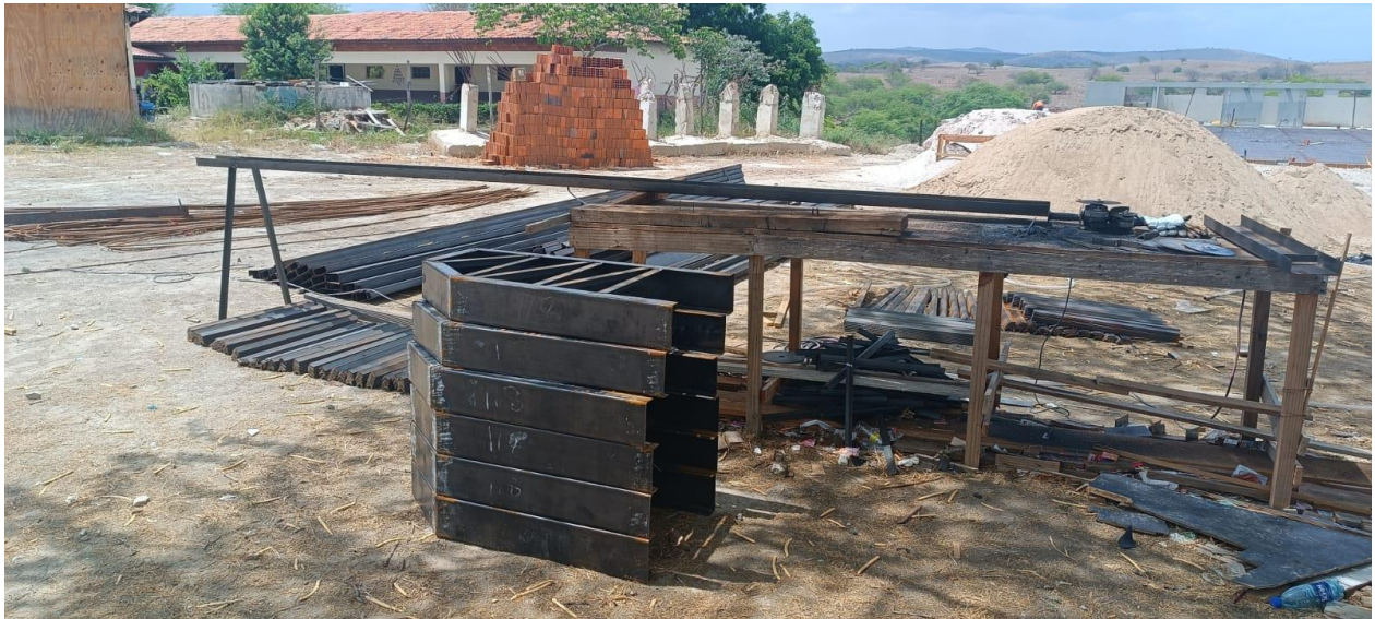
Figura 1: Execução de estrutura metálica.
