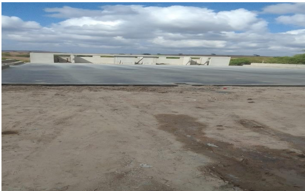
Figura 10: Piso apos concretagem
