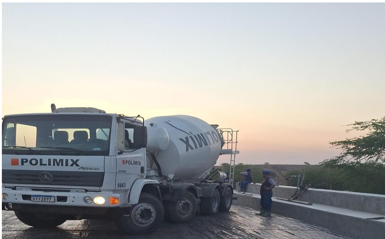
Figura 8: concretagem do psio
