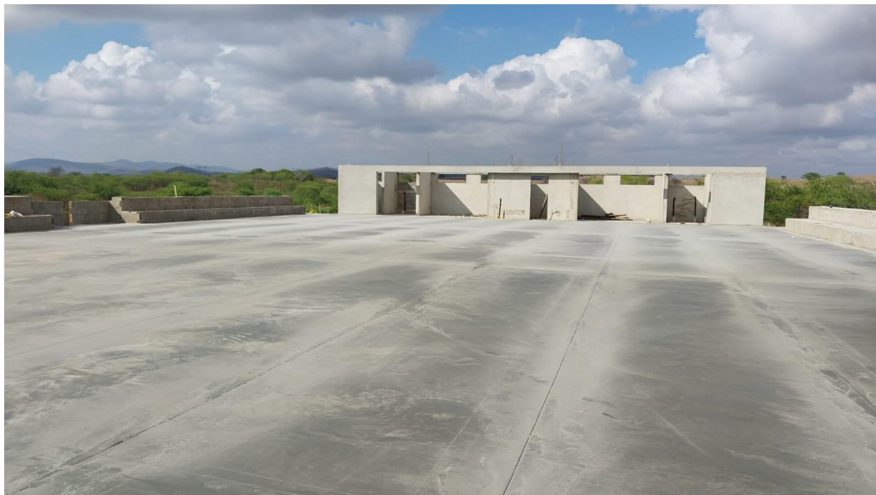
Figura 9: Corte para junta de dilatação
