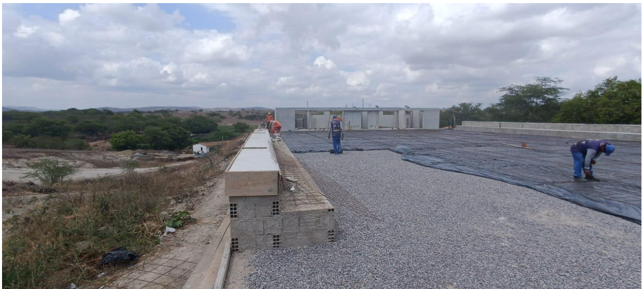
Figura 2: Camada de brita e tela para piso da quadra.
