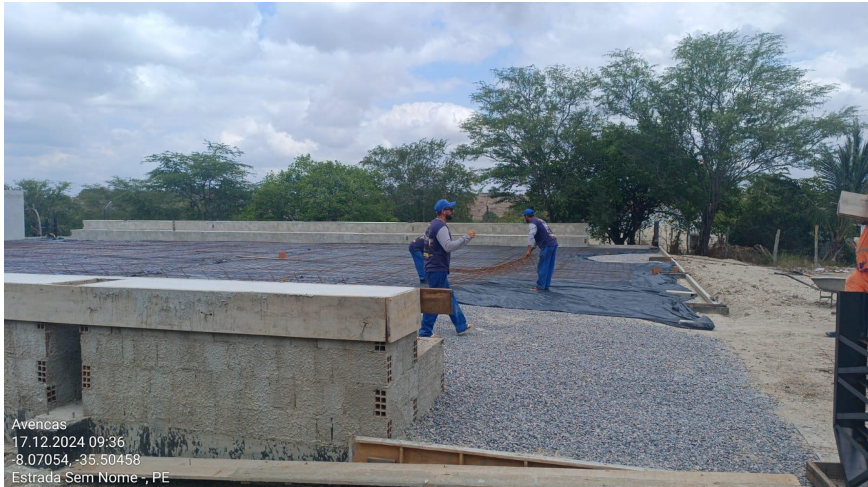
Figura 3: Camada de brita e tela para piso da quadra.
