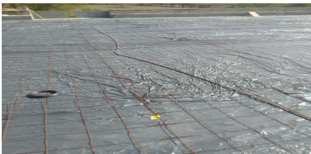
Figura 6: Armação do piso da Quadra
