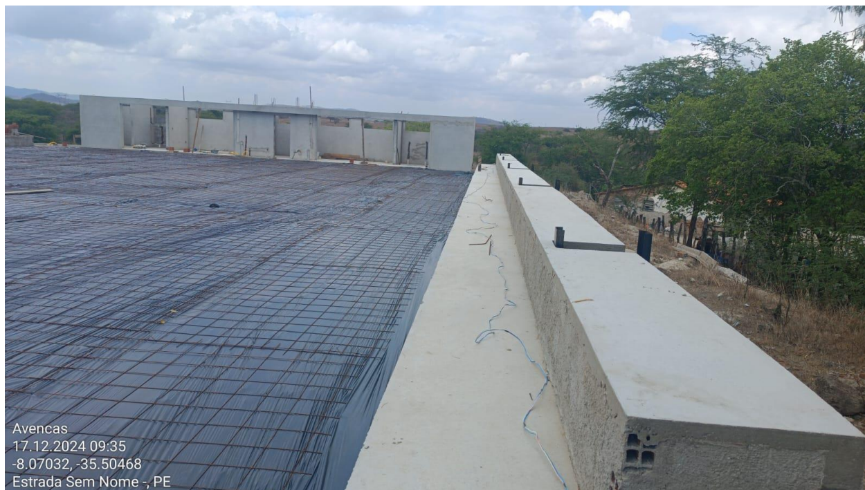
Figura 5: Arquibancadas concretadas.
