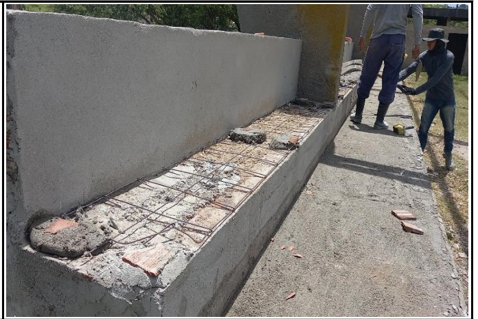
FOTO 08: Ferragens da arquibancadas.
