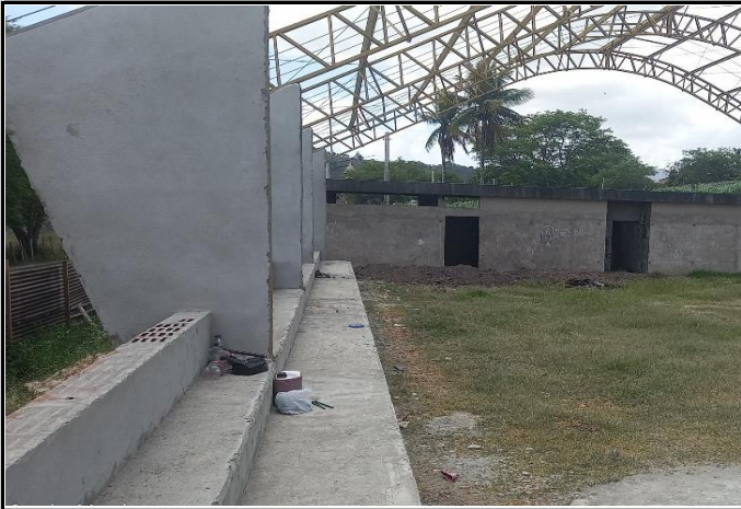
FOTO 07: Concreto das arquibancadas.
