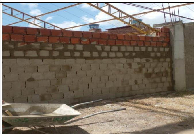
FOTO 06: Alvenaria de fechamento.
