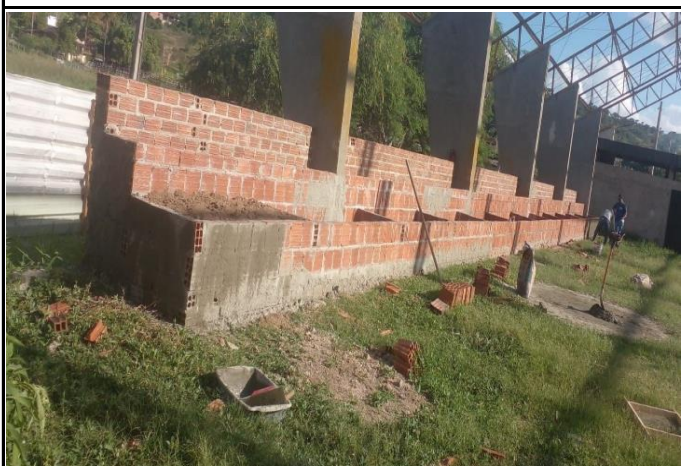
FOTO 05: Alvenaria das arquibancadas.
