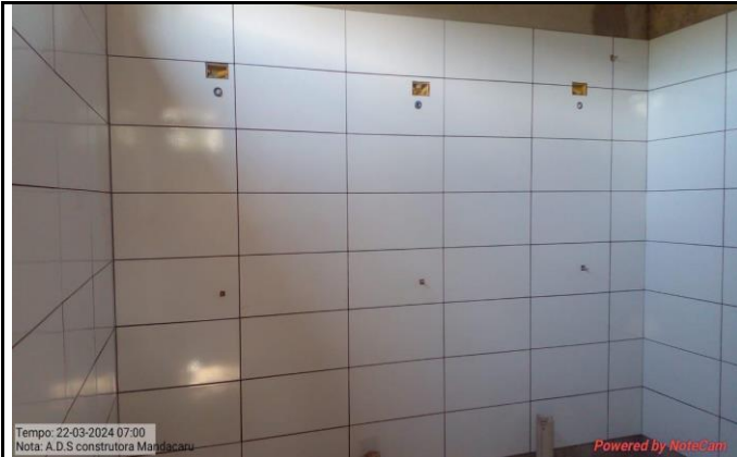
FOTO 01: PONTO HIDRAULICO CHUVEIRO
