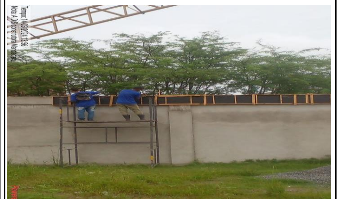
Tempo: 14-02-2024 13:35 Nota: A.D.S construtora Mandacari FOTO 10: REBOCO FACHADA 4
