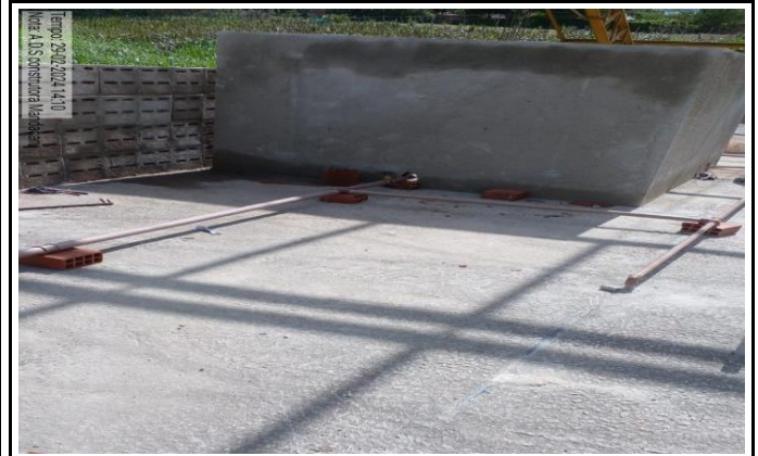
Tempo: 29-02-2024 14:10 Nota: A.D.S construtora Mandacari FOTO 12: INSTALAÇÃO DE AGUA FRIA
