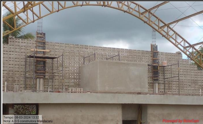
FOTO 03: ALVENARIA CAIXA D'AGUA
