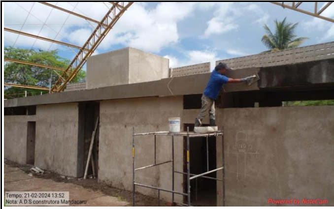
Tempo: 21-02-2024 13:52 Nota: A.D.S construtora Mandacari FOTO 07: REBOCO VESTIARIO
