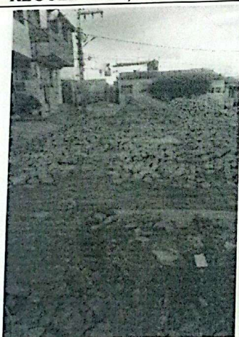
EXECUÇÃO DA PAVIMENTAÇÃO
