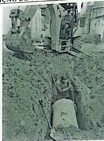
ADIÇÃO DE TUBOS DE CONCRETO
