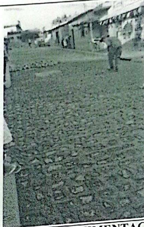
EXECUÇÃO DA PAVIMENTAÇÃO
