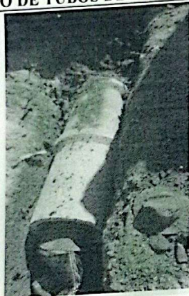
ADIÇÃO DE TUBOS DE CONCRETO
