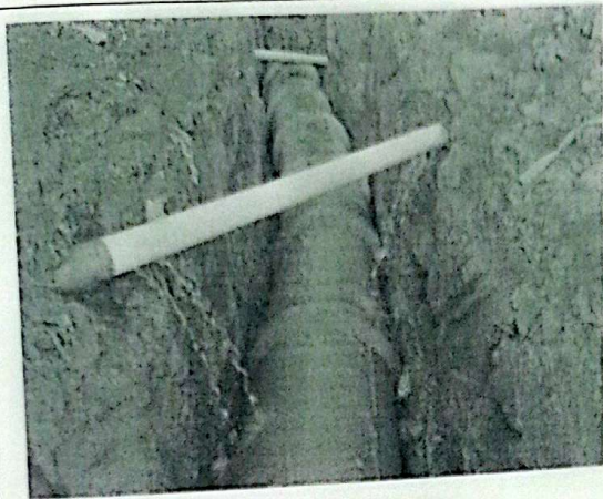
ADIÇÃO DE TUBOS DE CONCRETO
