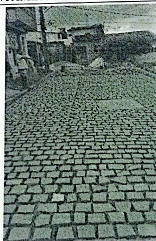
EXECUÇÃO DA PAVIMENTAÇÃO
