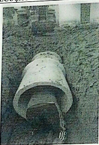
ADIÇÃO DE TUBOS DE CONCRETO
