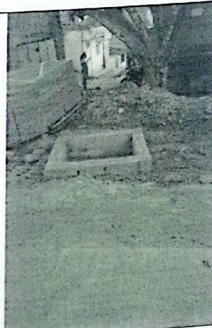
EXECUÇÃO DE BSL
