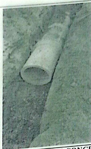
ADIÇÃO DE TUBOS DE CONCRETO
