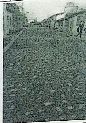
EXECUÇÃO DA PAVIMENTAÇÃO
