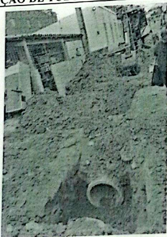
ADIÇÃO DE TUBOS DE CONCRETO
