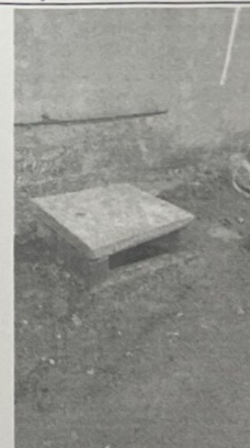
EXECUÇÃO DE BOCA DE LOBO
