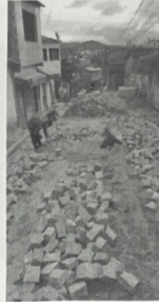
EXECUÇÃO DE PAVIMENTAÇÃO
