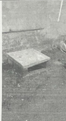
EXECUÇÃO DE BOCA DE LOBO
