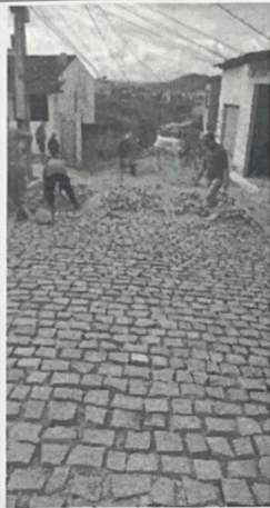
EXECUÇÃO DE PAVIMENTAÇÃO
