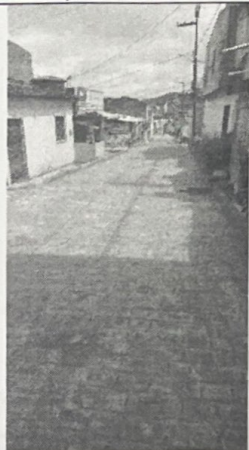
EXECUÇÃO DE PAVIMENTAÇÃO
