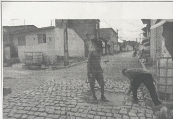
EXECUÇÃO DE PAVIMENTAÇÃO
