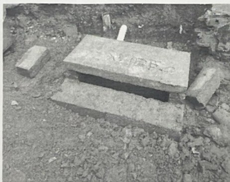
EXECUÇÃO DE BOCA DE LOBO
