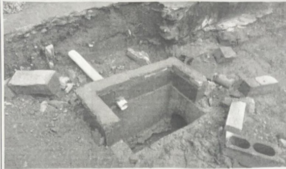
EXECUÇÃO DE BOCA DE LOBO
