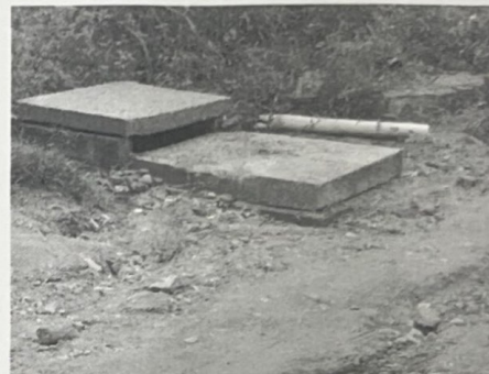
EXECUÇÃO DE BOCA DE LOBO
