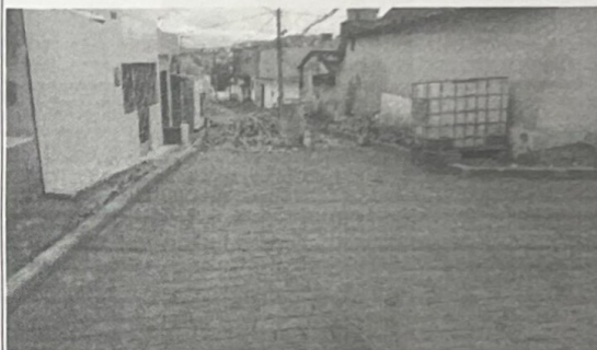
EXECUÇÃO DE PAVIMENTAÇÃO
