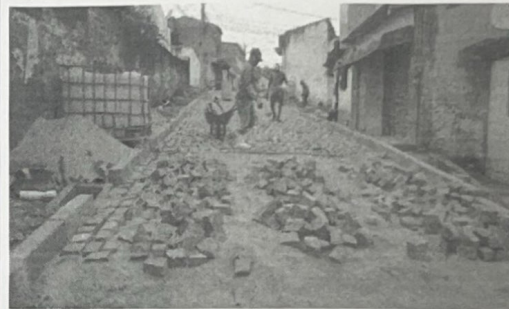
EXECUÇÃO DE PAVIMENTAÇÃO
