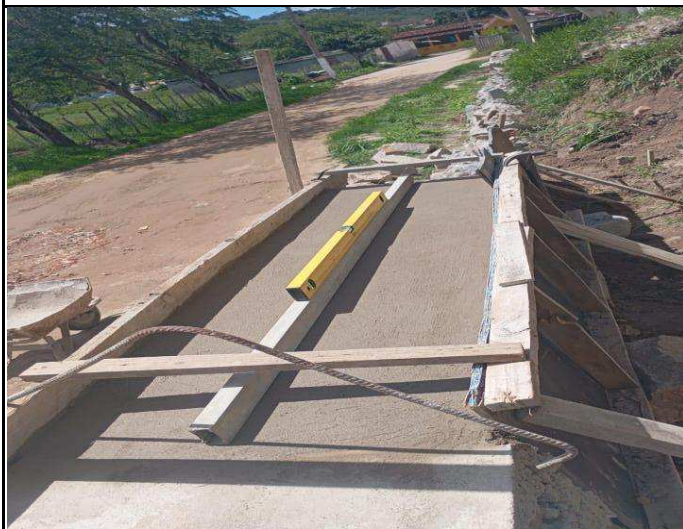
FOTO 01: EXECUÇÃO DO MURO DE ARRIMO
