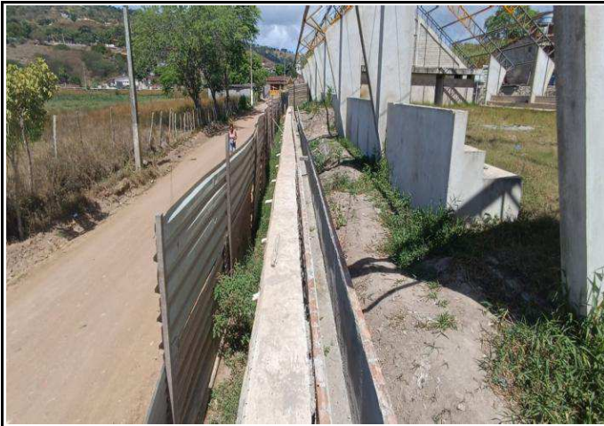
FOTO 07: EXECUÇÃO DE CANALETA
