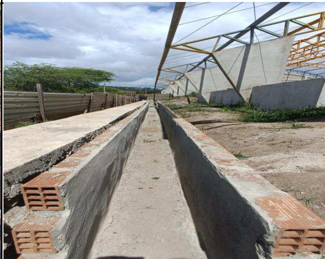
FOTO 02: EXECUÇÃO DE CANALETA
