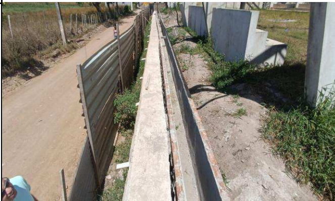
FOTO 04: EXECUÇÃO DE CANALETA
