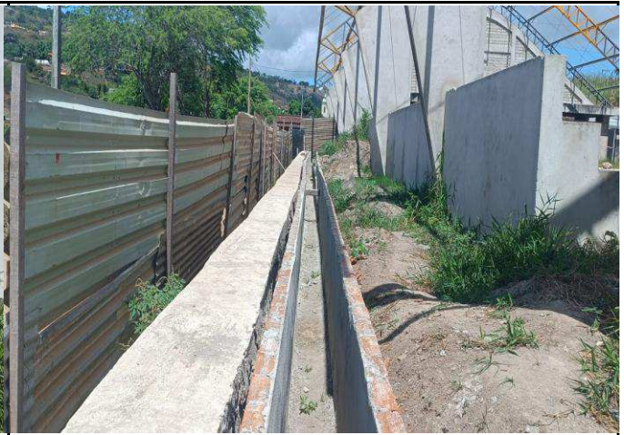
FOTO 08: EXECUÇÃO DE CANALETA
