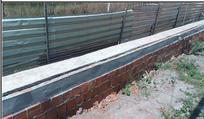
FOTO 03: FINALIZAÇÃO DE CANALETA E PREPARAÇÃO PARA ATERRO
