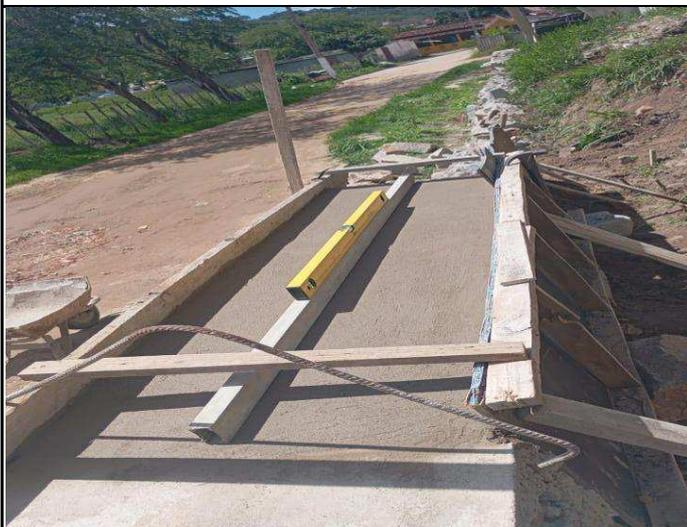
FOTO 01: EXECUÇÃO DO MURO DE ARRIMO
