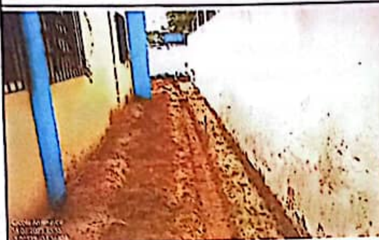
FOTO 01: Vala para passagem dos tubos.
