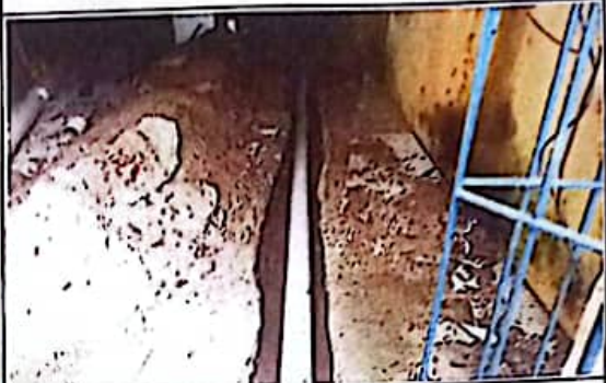
FOTO 02: Assentamento dos tubos de 150mm.
