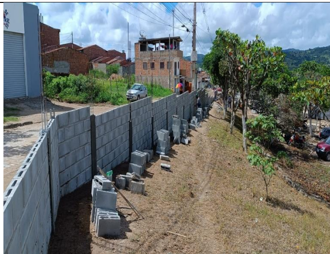
FOTO 03: PILARES E ALVENARIA DE MURO 01
