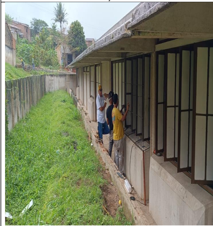
FOTO 06: INSTALAÇÃO DE GRADES DE PROTEÇÃO
