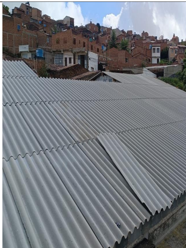
FOTO 10: COBERTA CRECHE, TELHAS EM FIBROCIMENTO 02
