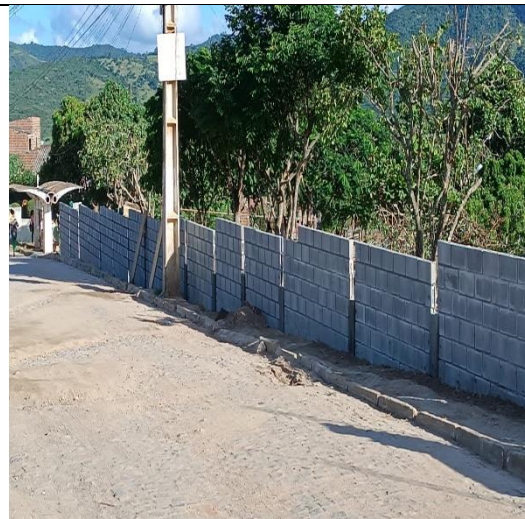
FOTO 04: PILARES E ALVENARIA DE MURO 02
