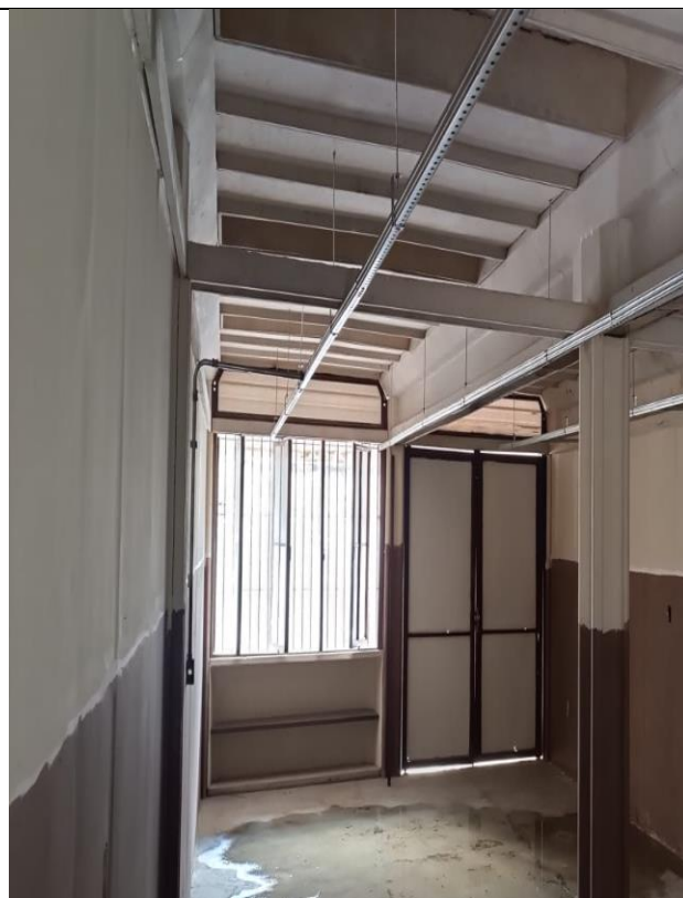
FOTO 14: INSTALAÇÃO DE ELETROCALHA METALICA 02
