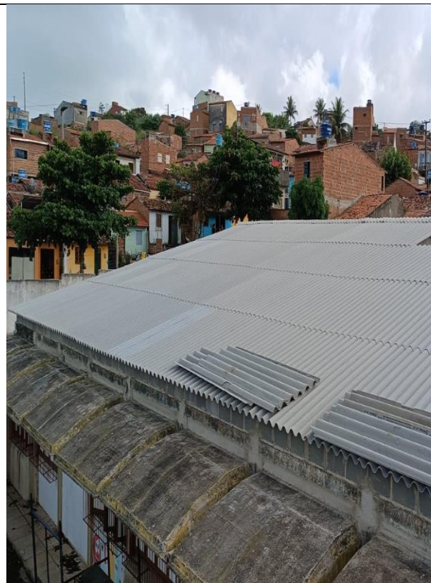
FOTO 09: COBERTA CRECHE, TELHAS EM FIBROCIMENTO 01
