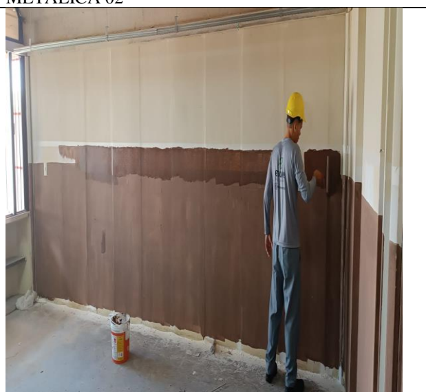
FOTO 16: EXECUÇÃO DE PINTURA DA CRECHE 02
