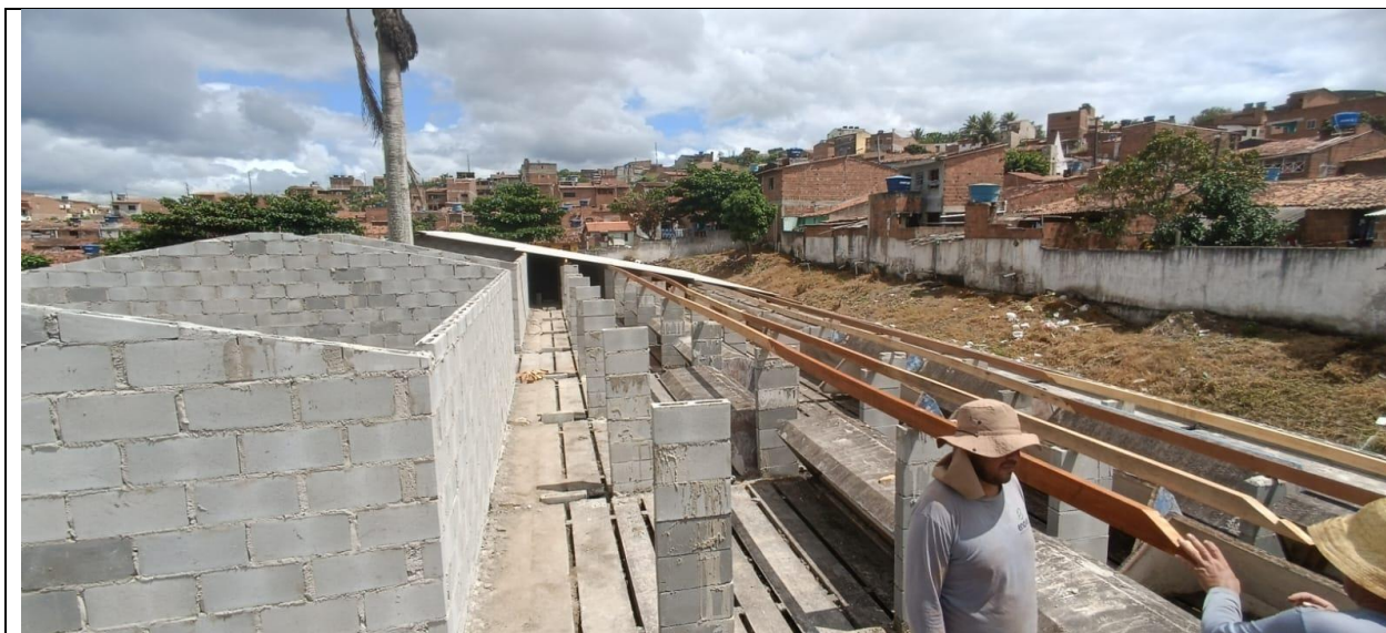
FOTO 08: INSTALAÇÃO DE LINHAS- COBERTA CRECHE.
