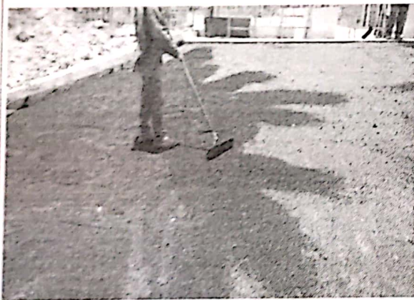
PINTURA E APLICAÇÃO DE CBUQ
