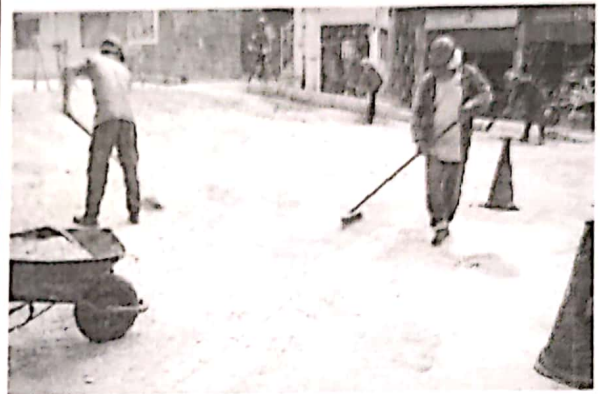
LIMPEZA E PREPARAÇÃO PARA APLICAÇÃO DE CBUQ
