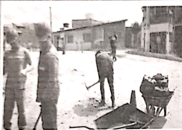
LIMPEZA E PREPARAÇÃO PARA APLICAÇÃO DE CBUQ
