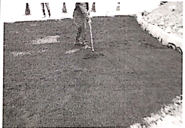
LIMPEZA E PREPARAÇÃO PARA APLICAÇÃO DE CBUQ
