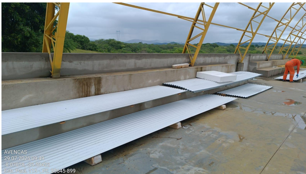
Figura 1: Telhas metálicas da cobertura.
