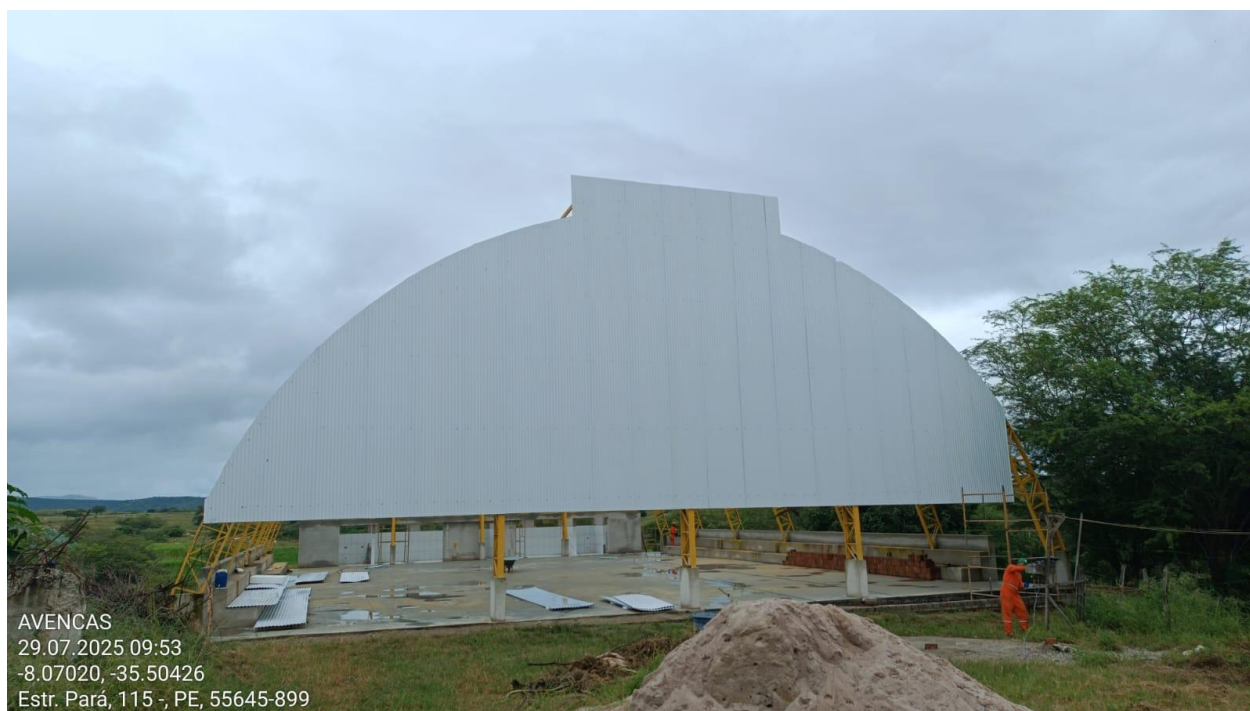
Figura 6: Instalação das telhas da cobertura.
