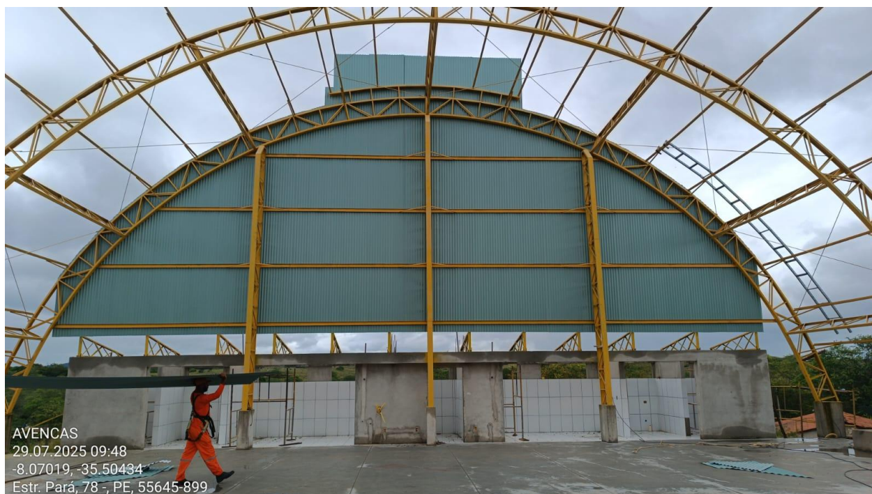
Figura 4: Instalação das telhas da coberta.
