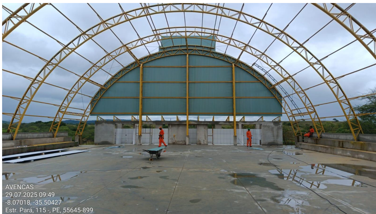
Figura 5: Instalação das telhas da coberta.
