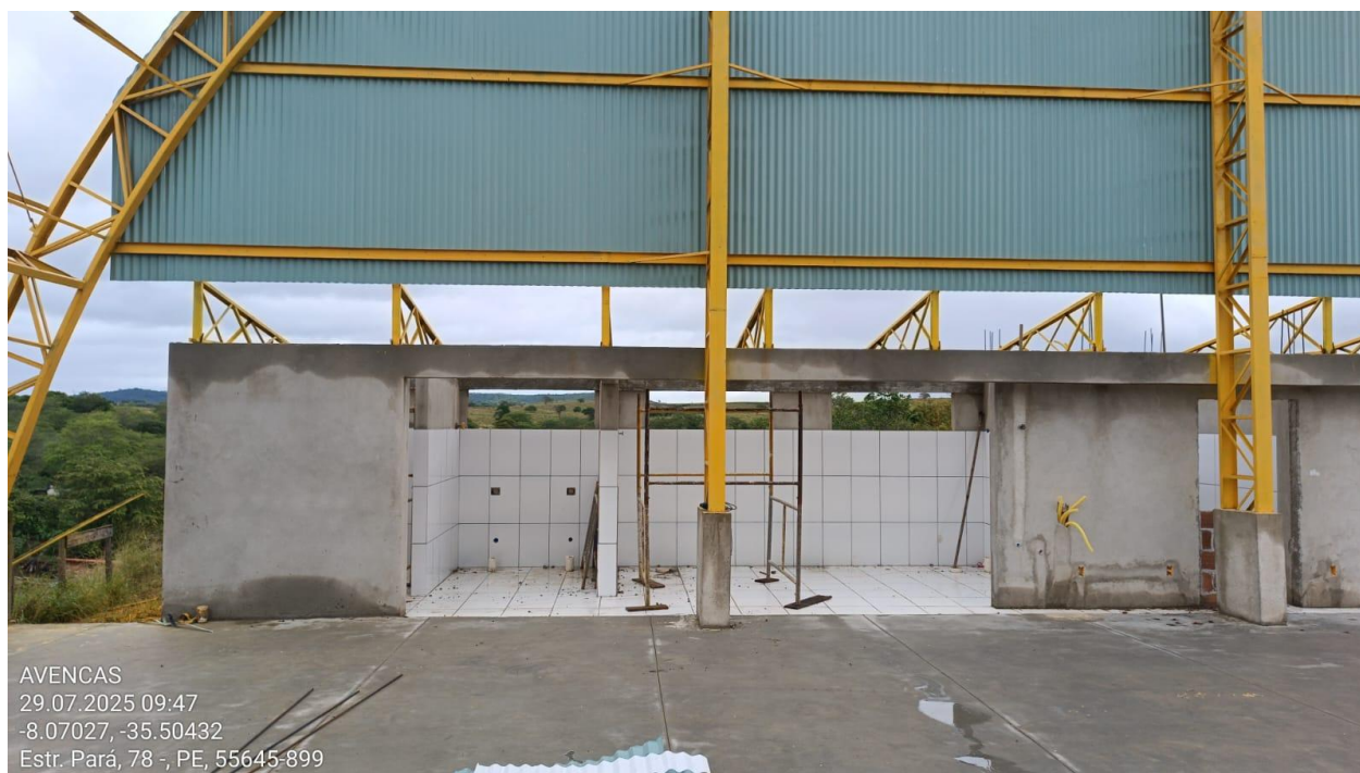
Figura 3: Instalação das telhas da coberta.
