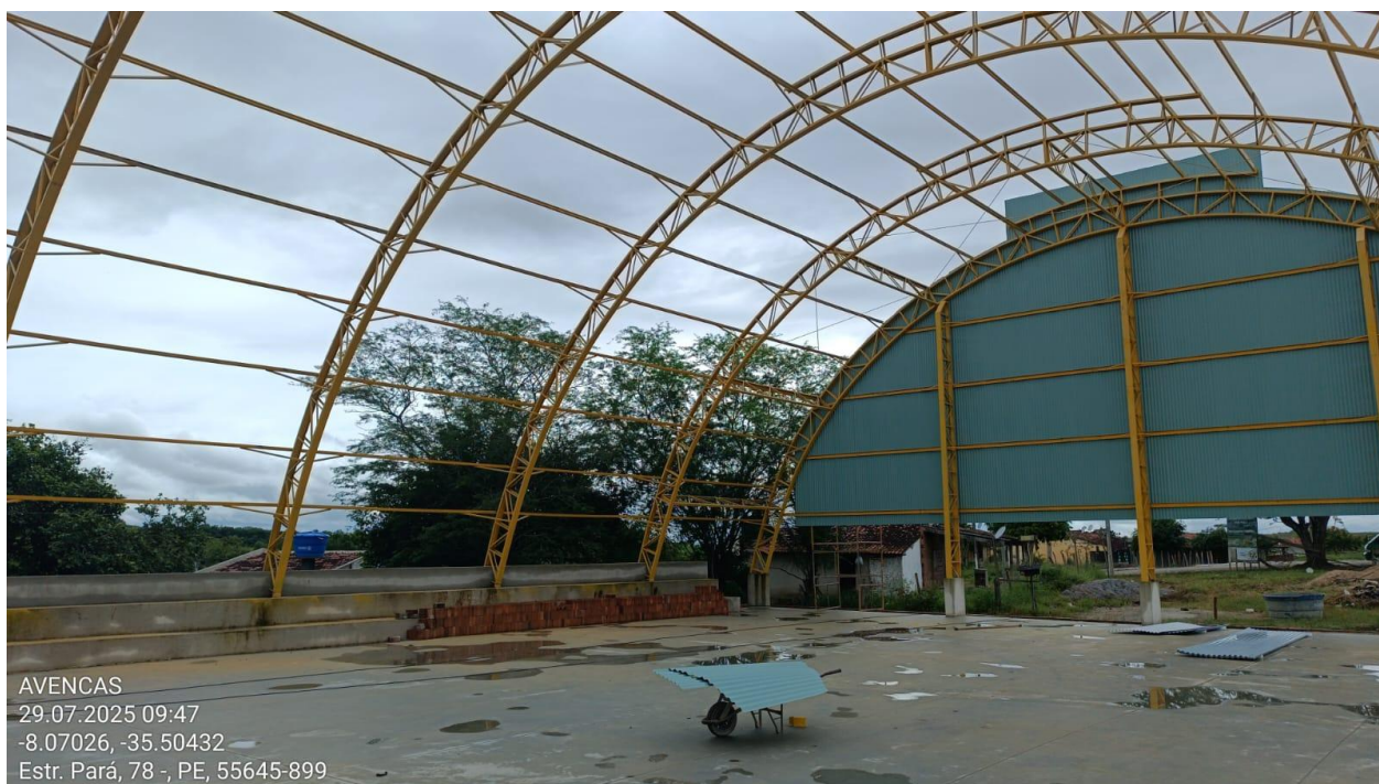
Figura 2: Instalação das telhas da cobertura.
