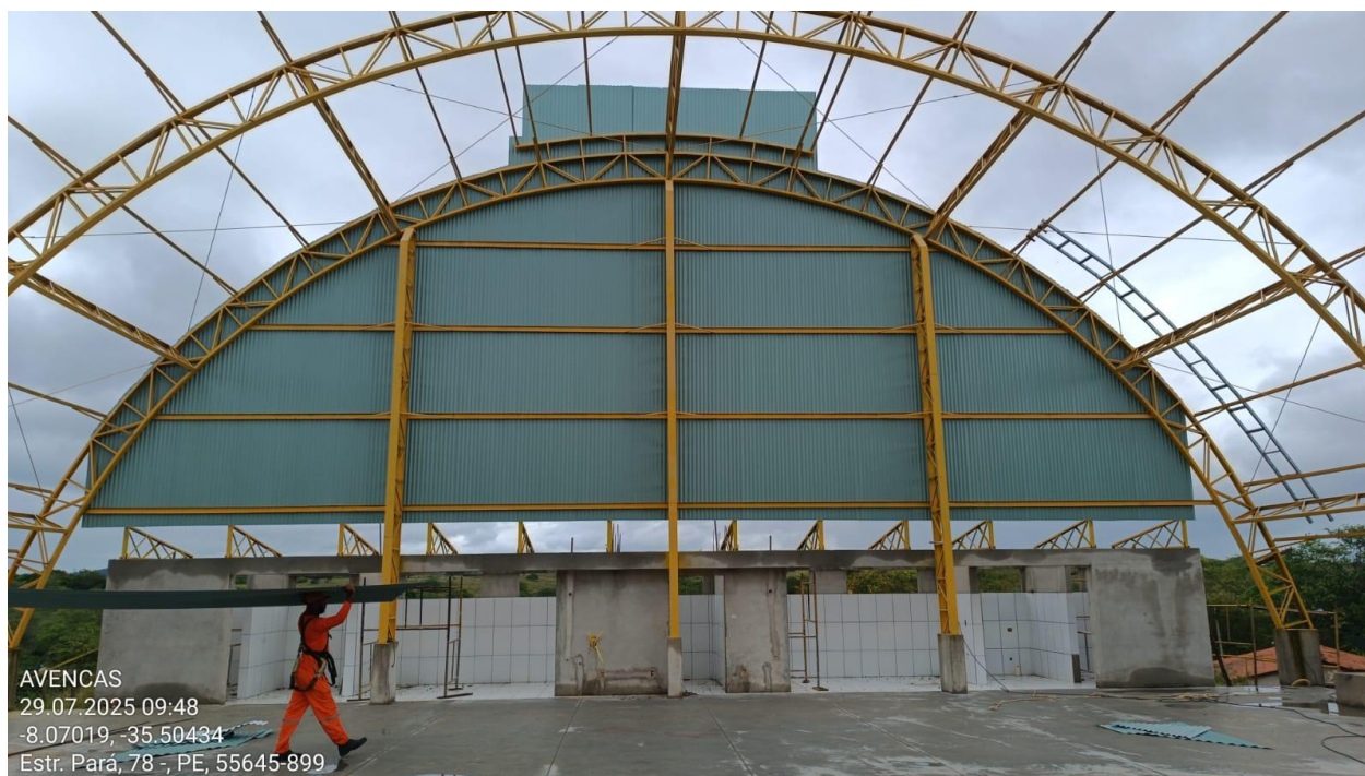
Figura 4: Instalação das telhas da coberta.
