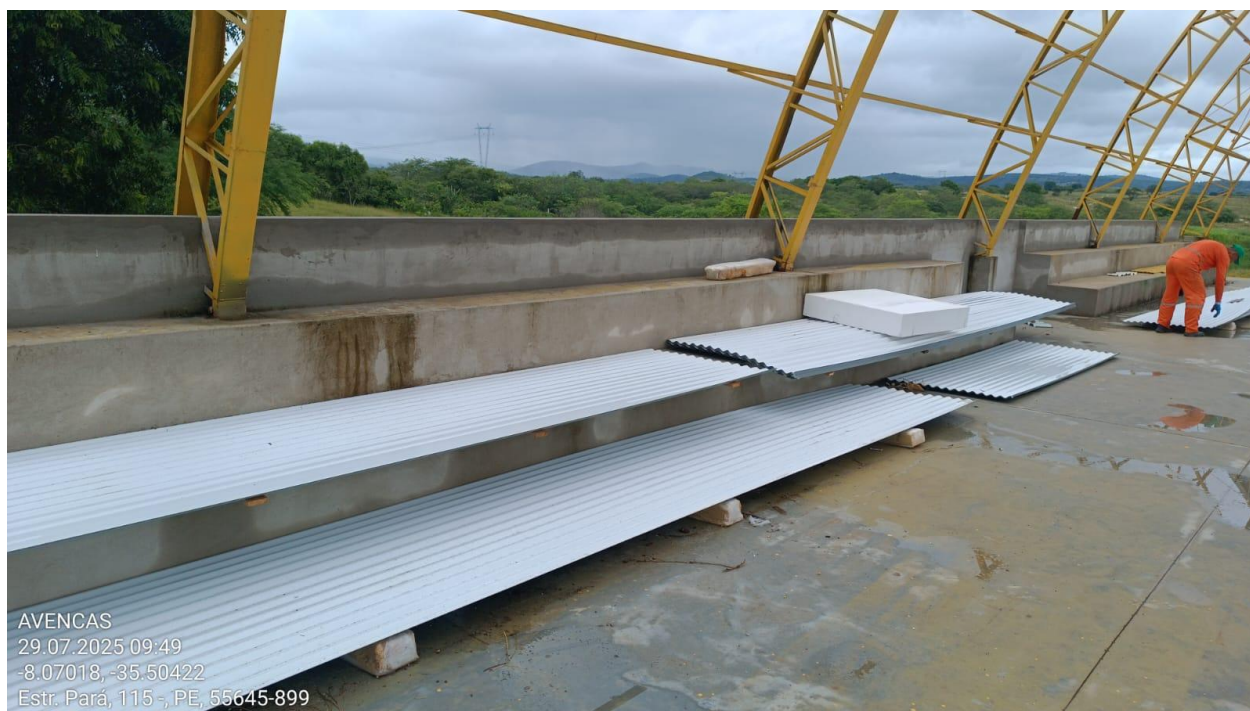
Figura 1: Telhas metálicas da cobertura.
