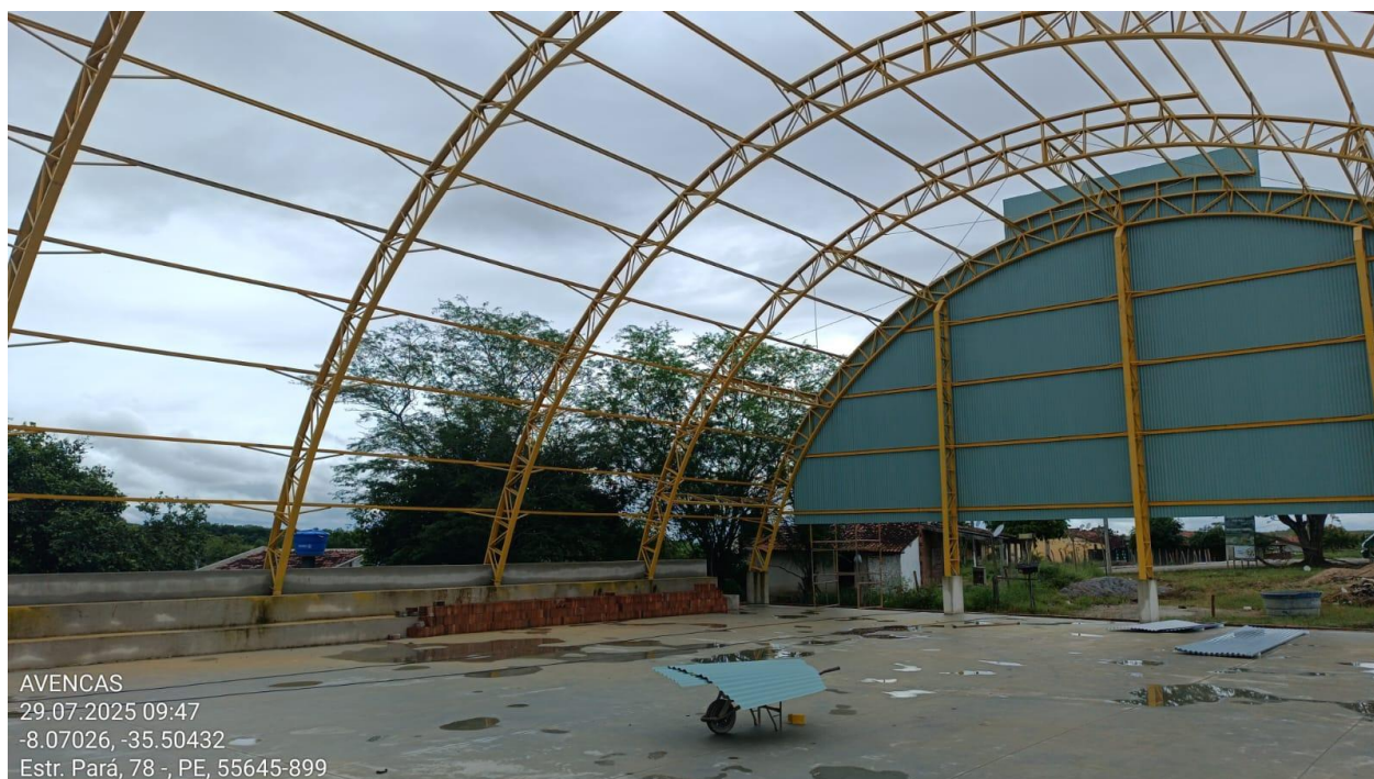
Figura 2: Instalação das telhas da cobertura.
