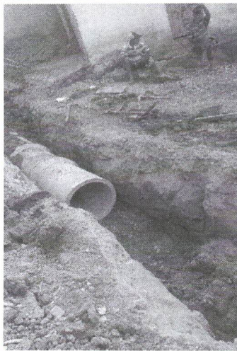
EXECUÇÃO DE ATERRO
