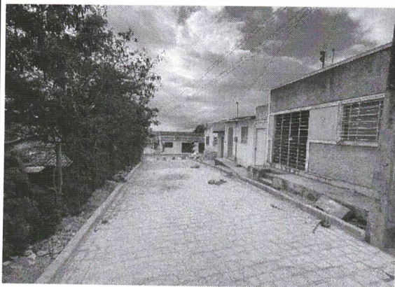
EXECUÇÃO DA PAVIMENTAÇÃO
