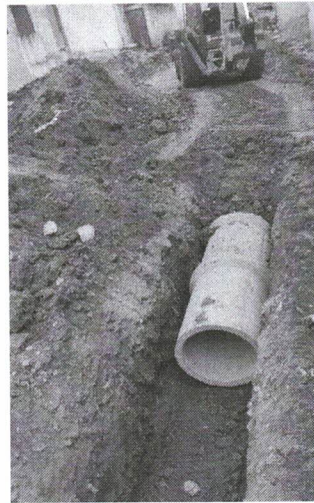
EXECUÇÃO DE ATERRO
