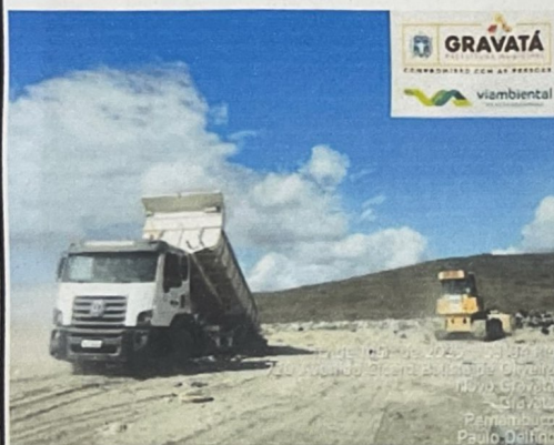
RECOBRIMENTO DA MASSA DE LIXO
