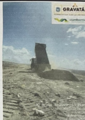
RECOBRIMENTO DA MASSA DE LIXO
