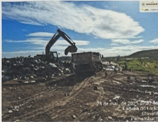
24 de mai. de 2025 07:37:34 Ladeira do Lixão Gravatá Pernambuco RECOLHIMENTO DO LIXO DOMICILIAR PARA A CÉLULA EM ATIVIDADE, O MATERIAL FOI DESCARREGADO ANTES DEVIDO AO VOLUME DE CHUVAS DIFICULTANDO O ACESSO A MESMA.
