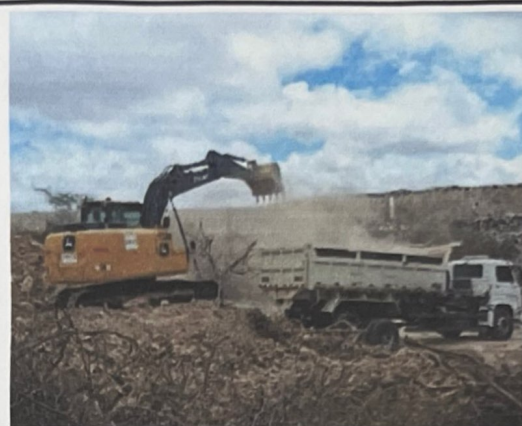
RECOBRIMENTO DA MASSA DE LIXO
