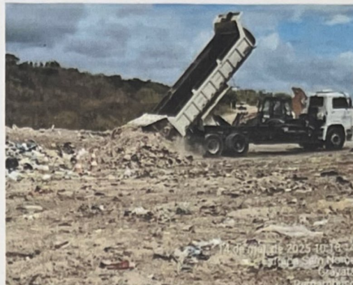
RECOBRIMENTO DA MASSA DE LIXO
