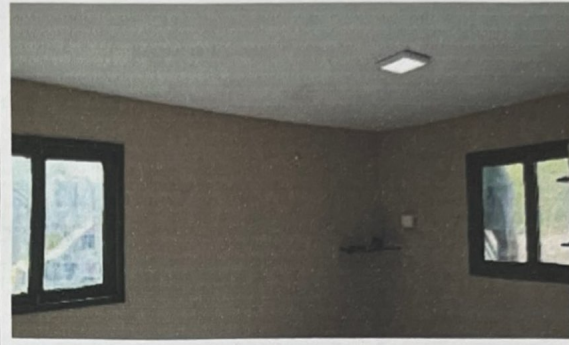
BALANÇA ATERRO - DEPOIS DA MANUTENÇÃO E REPAROS (REVISÃO HIDRAÚLICA, ELÉTRICA, COBERTA E PINTURA)
