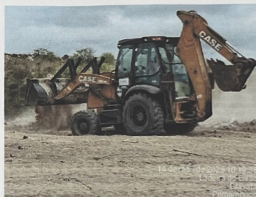
RECOBRIMENTO DA MASSA DE LIXO
