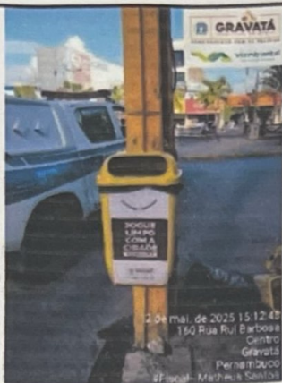
INSTALAÇÃO DE PAPELEIRAS
