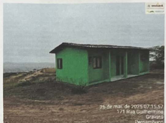
26 de mai. de 2025 07:15:57 171 Rua Guilhermina Gravatá Pernambuco PRÉDIO AMINISTRATIVO ATERRO - DEPOIS DA MANUTENÇÃO E REPAROS (REVISÃO HIDRAÚLICA, ELÉTRICA, COBERTA E
