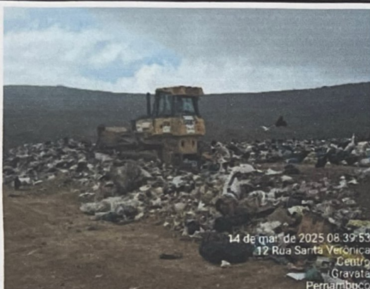
RECOBRIMENTO DA MASSA DE LIXO
