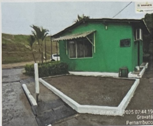
BALANÇA ATERRO - DEPOIS DA MANUTENÇÃO E REPAROS (REVISÃO HIDRAÚLICA, ELÉTRICA, COBERTA E PINTURA)
