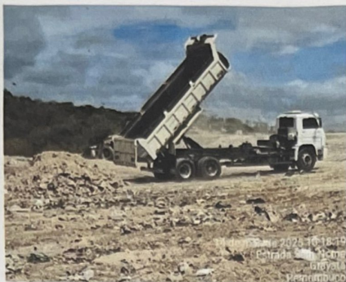
RECOBRIMENTO DA MASSA DE LIXO
