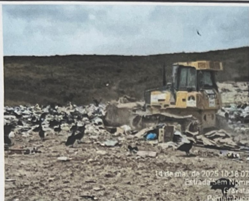
RECOBRIMENTO DA MASSA DE LIXO
