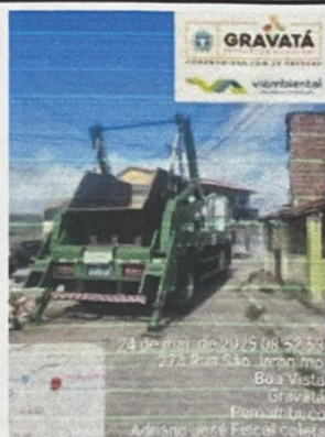
INSTALAÇÃO DAS CAIXAS 5M³
