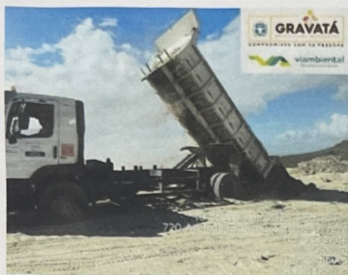
RECOBRIMENTO DA MASSA DE LIXO
