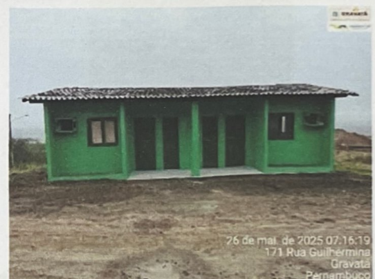
26 de mai. de 2025 07:16:19 171 Rua Guilhermina Gravatá Pernambuco PRÉDIO AMINISTRATIVO ATERRO - DEPOIS DA MANUTENÇÃO E REPAROS (REVISÃO HIDRAÚLICA, ELÉTRICA, COBERTA E
