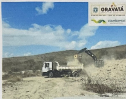
RECOBRIMENTO DA MASSA DE LIXO
