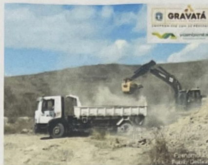
RECOBRIMENTO DA MASSA DE LIXO
